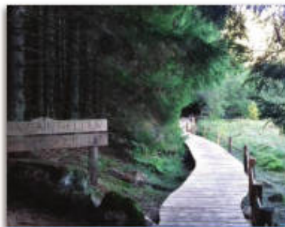
Construction d'un ponton au lac de Servières
