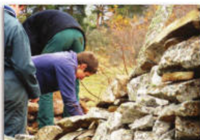
Restauration d'une cabane de berger
