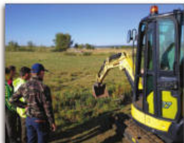
Restauration de berges avec notre mini-pelle
